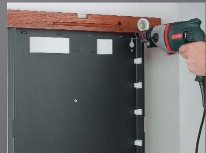
Vormontage: Wandhalterung wird Bohrschablone
